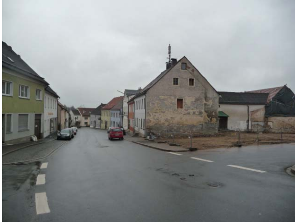
Abbildung 7: Das Gelände für das Gesundheitszentrum am Marktplatz nach dem Abriss der alten Gebäude
